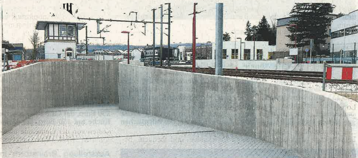
Die neue Unterführung für Fußgänger und Radfahrer am Bahnhof Mersch
